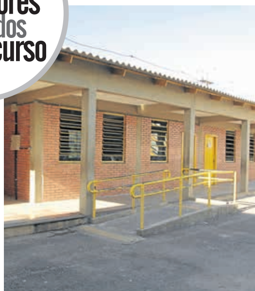
Novas salas de alvenaria e depósito na EMEF Erna Würth
