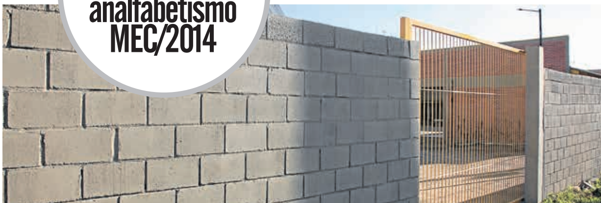
Novo muro na EMEF Erna Würth
