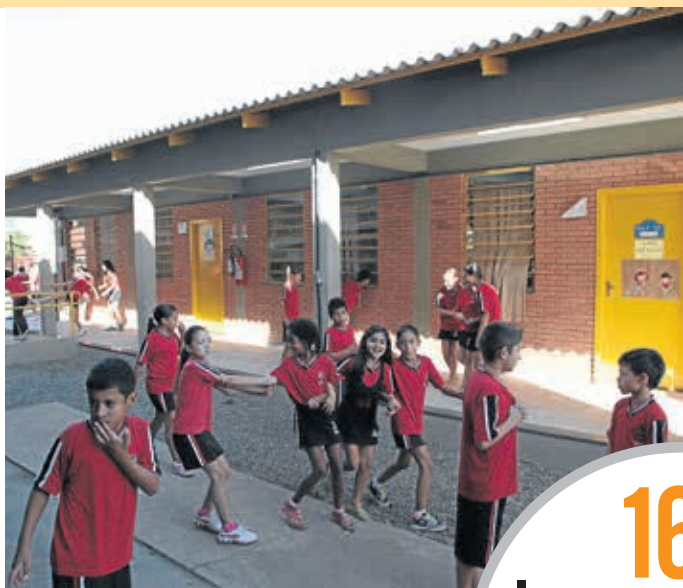
Ampliação da EMEF Odette Freitas
