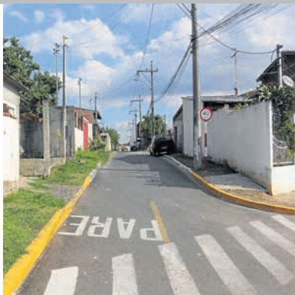
Asfalto do Beco 1 no Cheiro da Terra no Bairro Estância Velha
