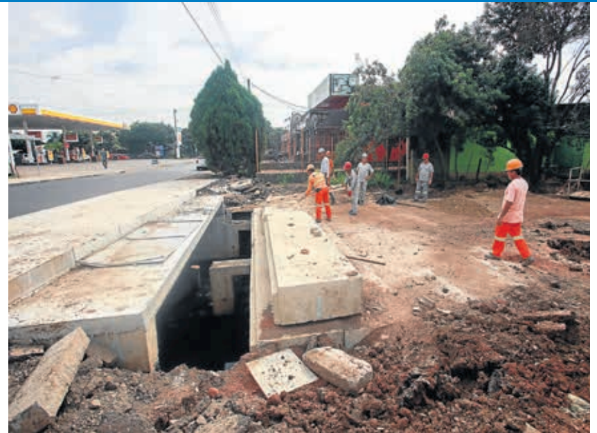
Obras na Vala da Florianópolis
