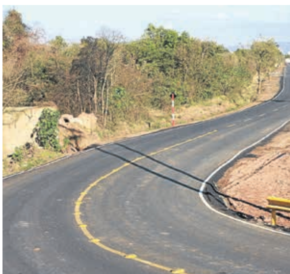
Asfalto da Rua Irineu de Carvalho Braga no Bairro Fátima
