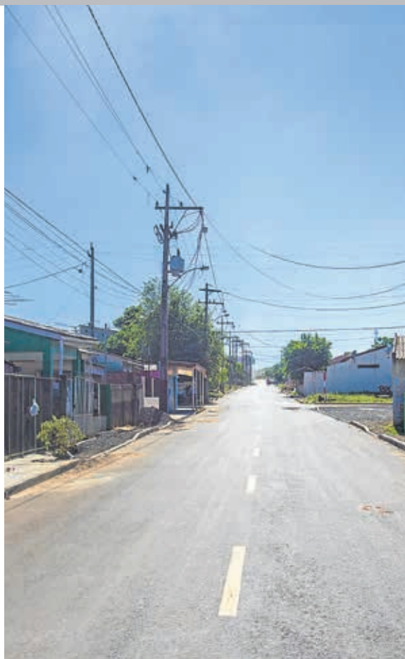
Asfalto da Rua Barbosa Lima Sobrinho até MQS no Bairro Guajuviras
