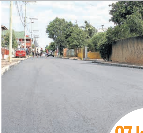
Asfalto da Rua Erechim na Vila Getúlio Vargas
