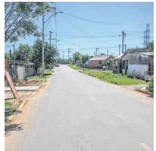
Asfalto da Rua 3 no Loteamento Comtel no Bairro Guajuviras
