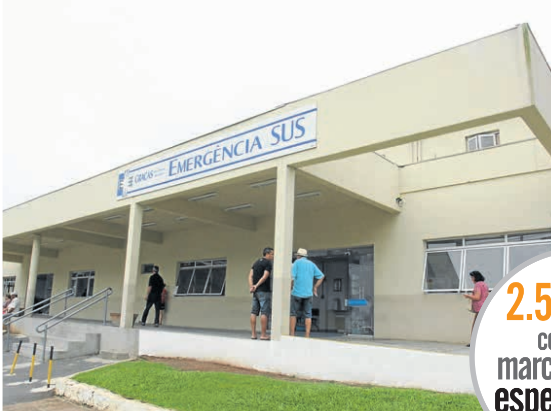
Construção da nova Emergência do Hospital Nossa Senhora das Graças
