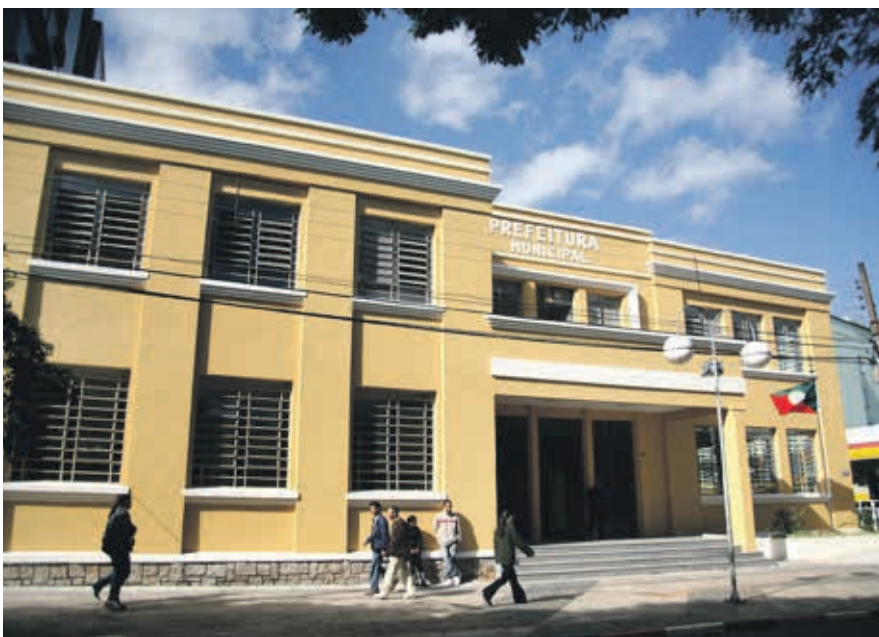
Restauração do Prédio Histórico da Prefeitura
