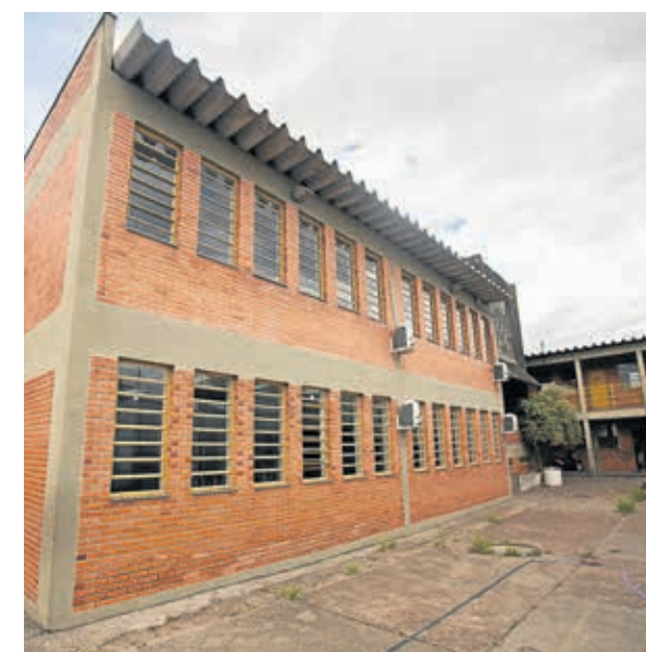
Ampliação de salas de aula na EMEF General Osório
