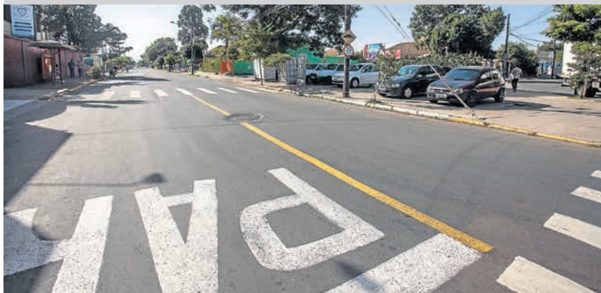
Após as obras, Rua Ana Neri recebe pavimentação
