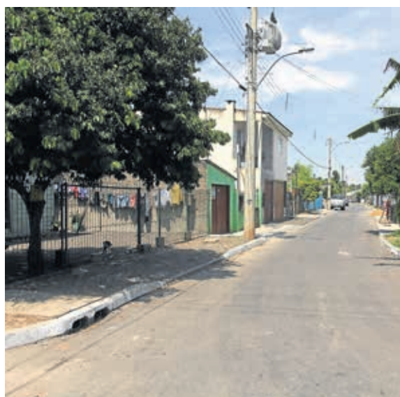
Asfalto da Rua 21 de Abril no João de Barro
