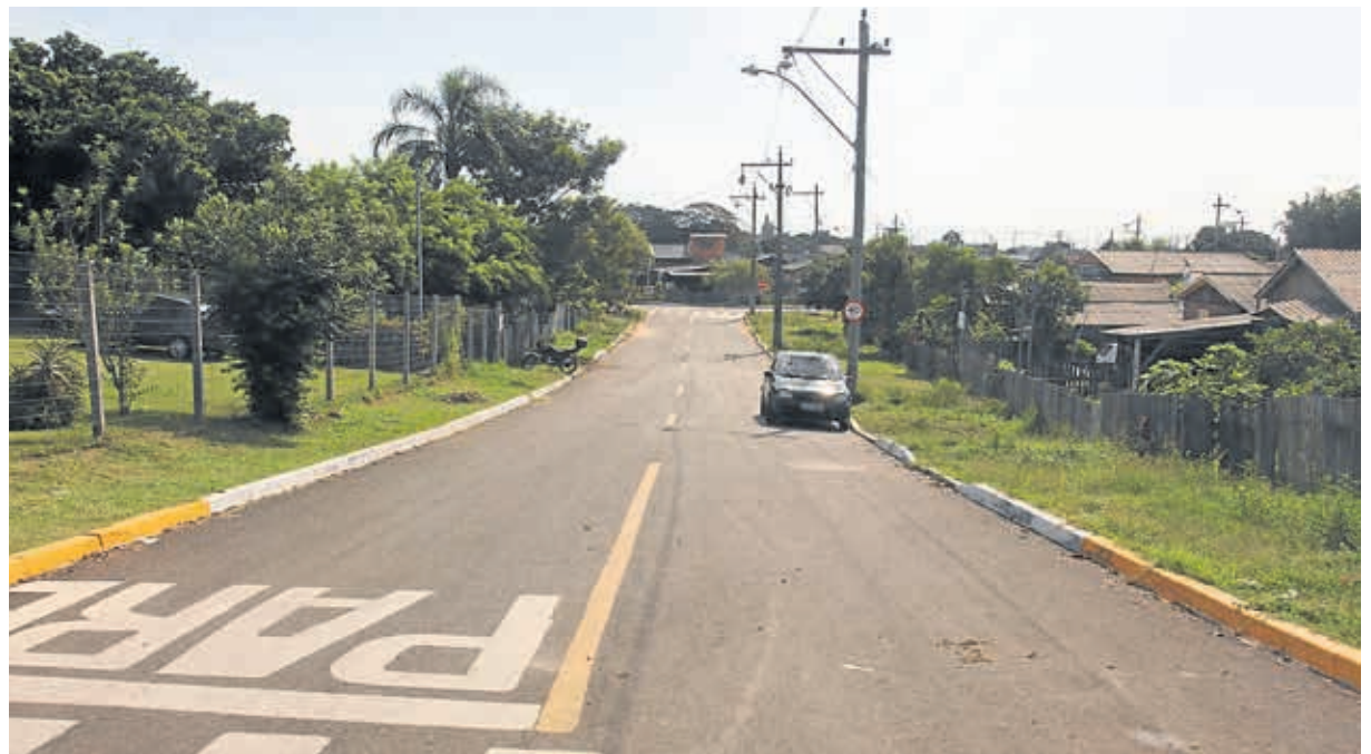
Asfalto da Rua Vista do Sol na Nancy Pansera
