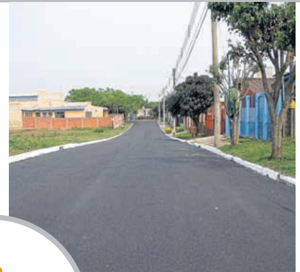
Asfalto da Rua Jaboticabas na Nova Estância
