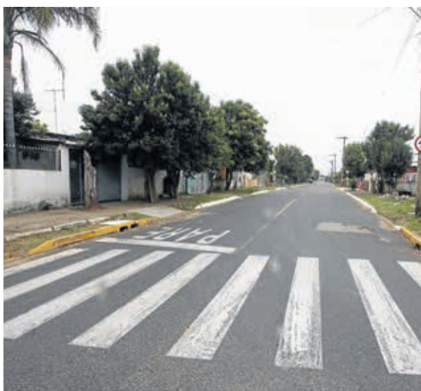
Asfalto da Rua Zumbi no Santo Operário
