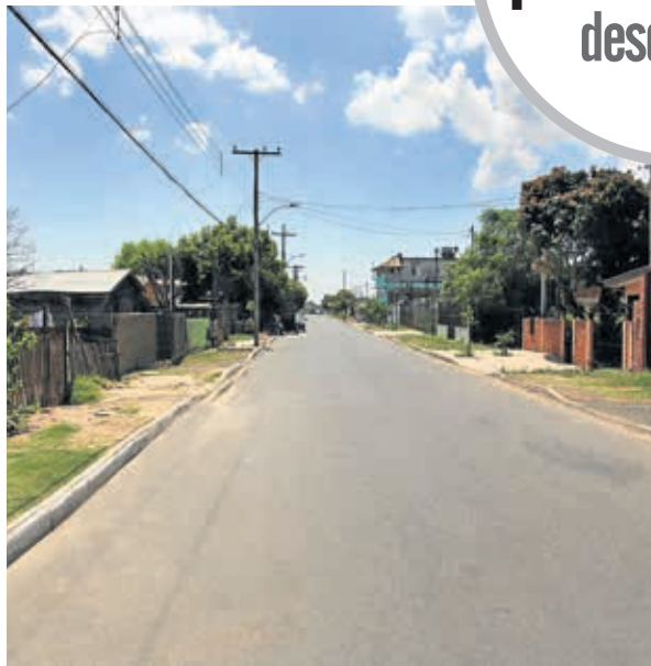
Asfalto da Rua João Marques no João de Barro
