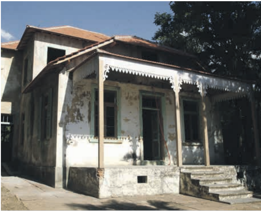
Restauração da Casa dos Rosa (em obras)
