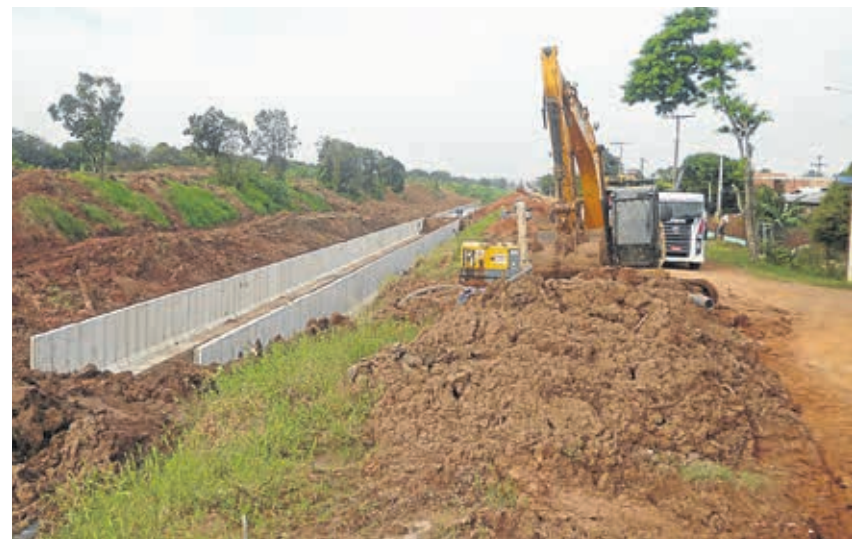
Obras na Vala da Curitiba nos bairros Mathias Velho e São Luís
