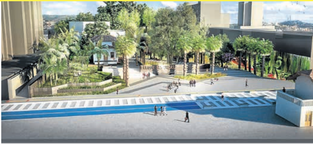
Parque das Taças em construção (junto às taças da Corsan)
