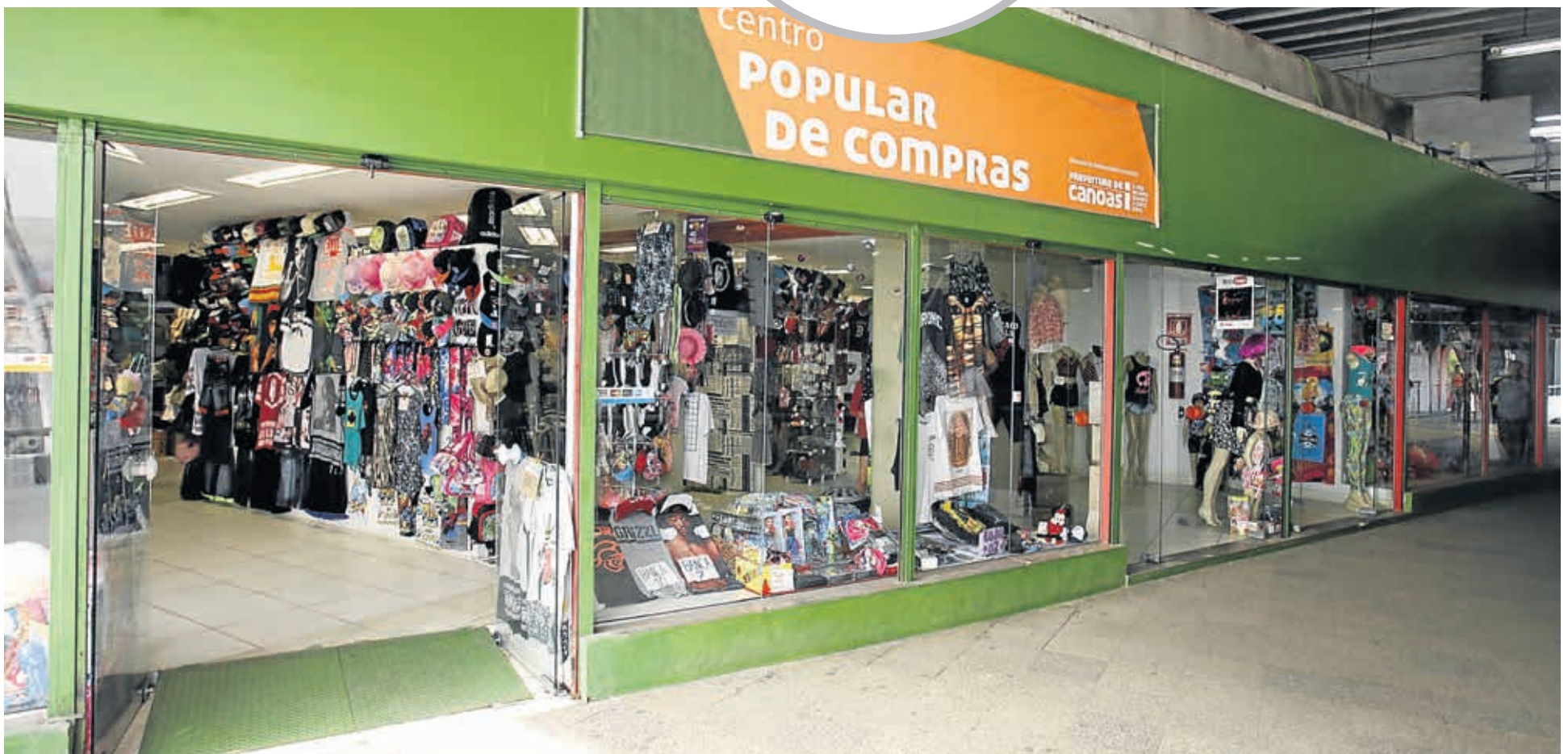
Construção do Centro Popular de Compras na Estação Canoas da Trensurb
