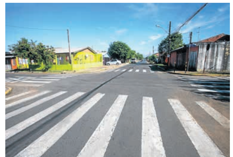
Asfalto da Rua Santo Antônio na Santo Operário
