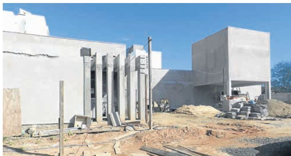
Construção do novo Centro de Especialidades Médicas (em obras no Centro de Canoas)
