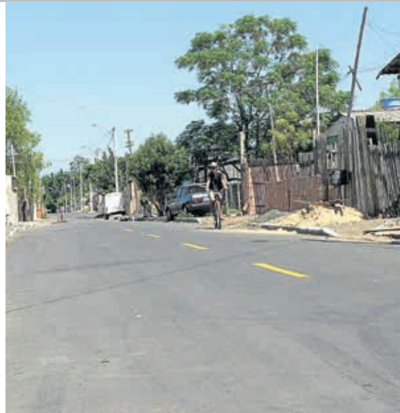
Asfalto da Rua Veranópolis no Bairro Rio Branco
