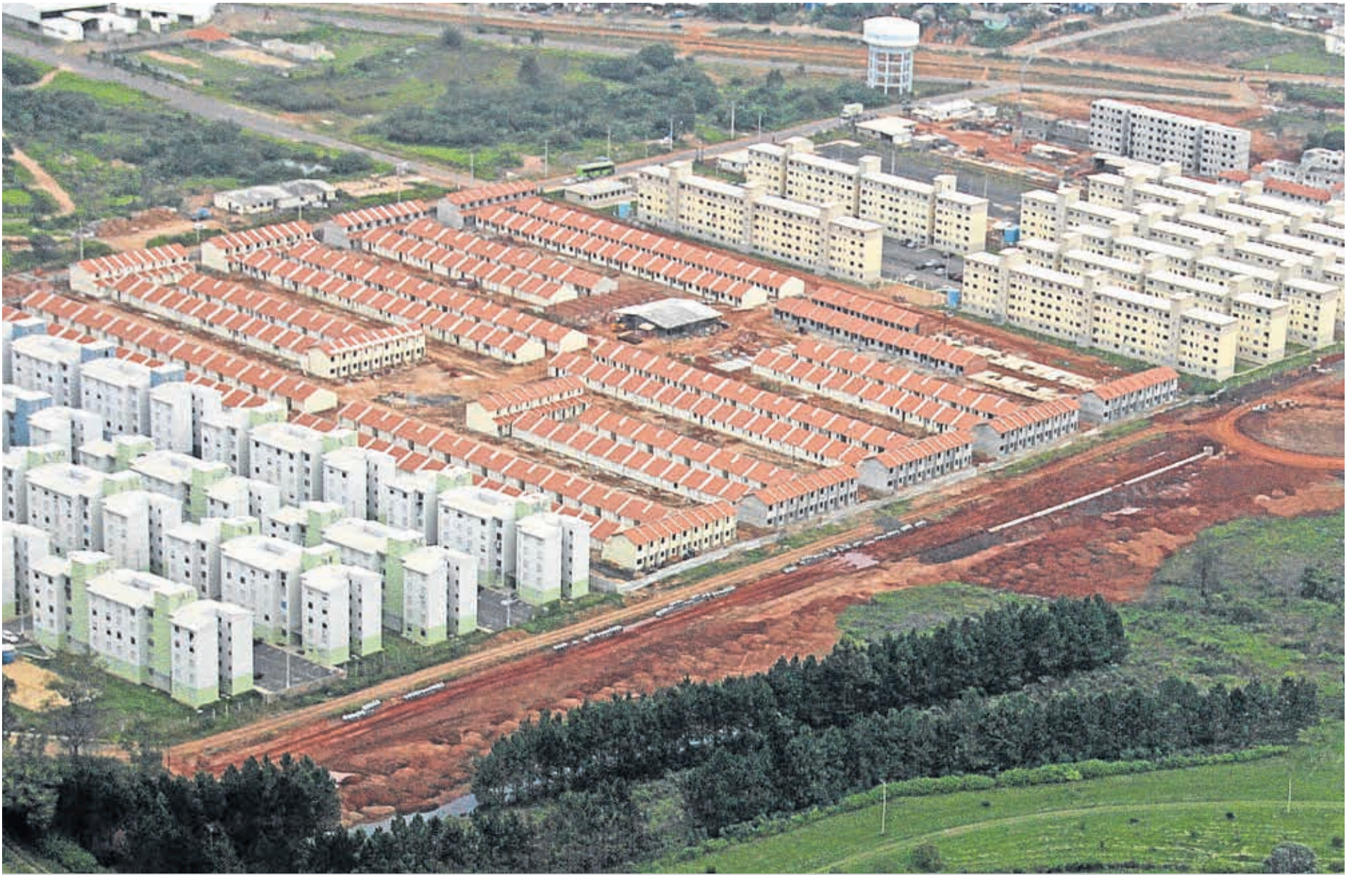
Construção de conjuntos habitacionais do Minha Casa Minha Vida no bairro Guajuviras
