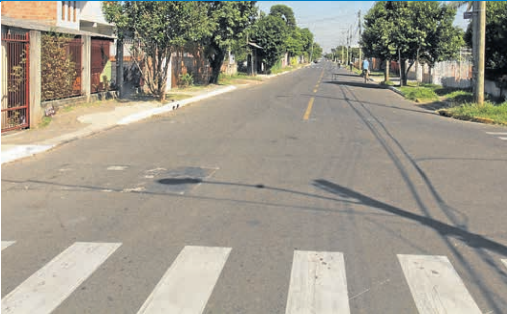
Galeria pluvial e pavimentação na Rua São João Batista na Santo Operário
