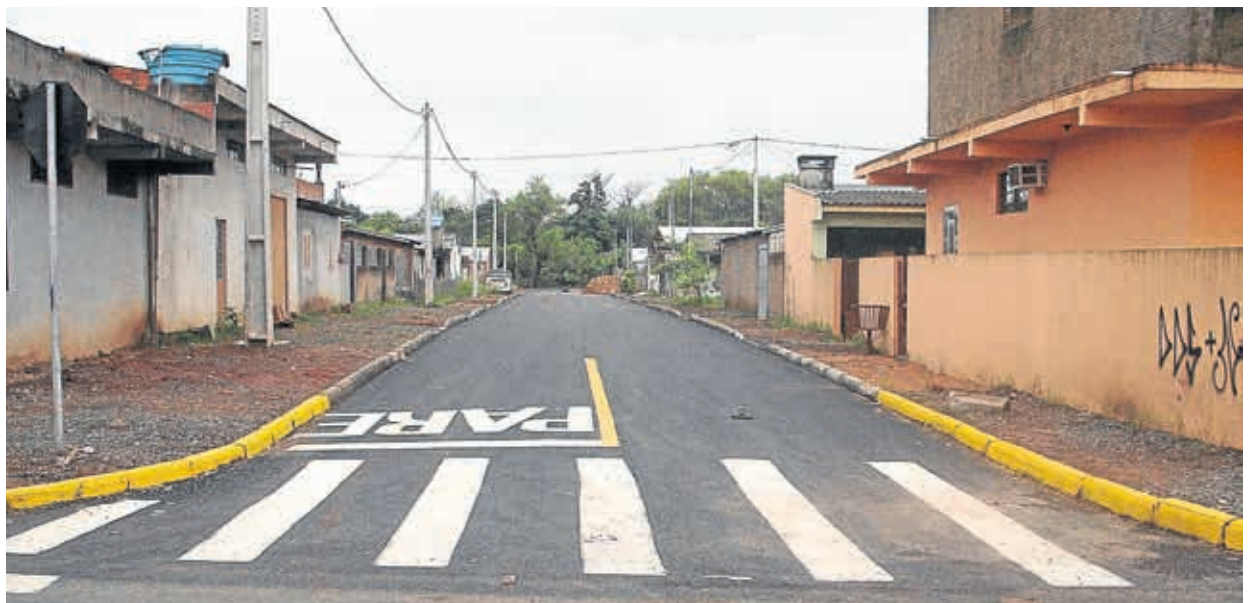
Asfalto da Rua Lima da Costa no Bairro Rio Branco
