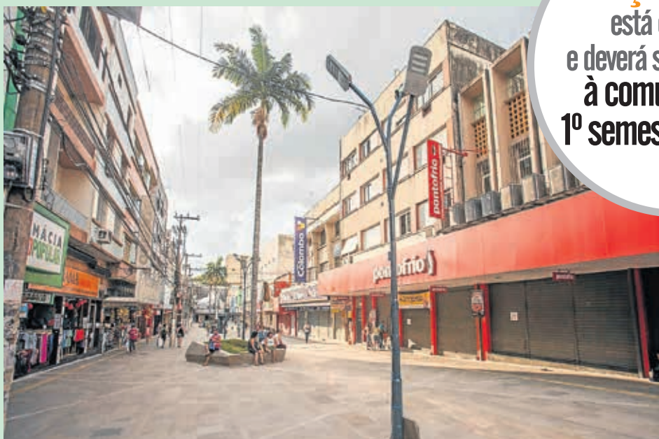
Calçadão levou 41 anos para ganhar intervenção urbanística com nova pavimentação, rede elétrica, hidráulica, mobiliário e iluminação.
