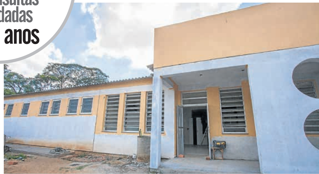
Ampliação e reforma da UBS Guajuviras (em andamento com novo padrão construtivo)
