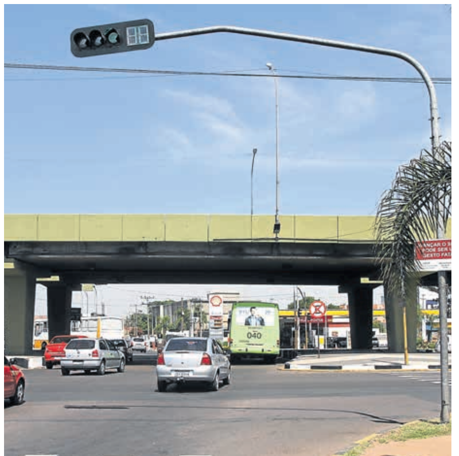
Novas sinaleiras de LED resultaram em 80% de economia de energia elétrica
