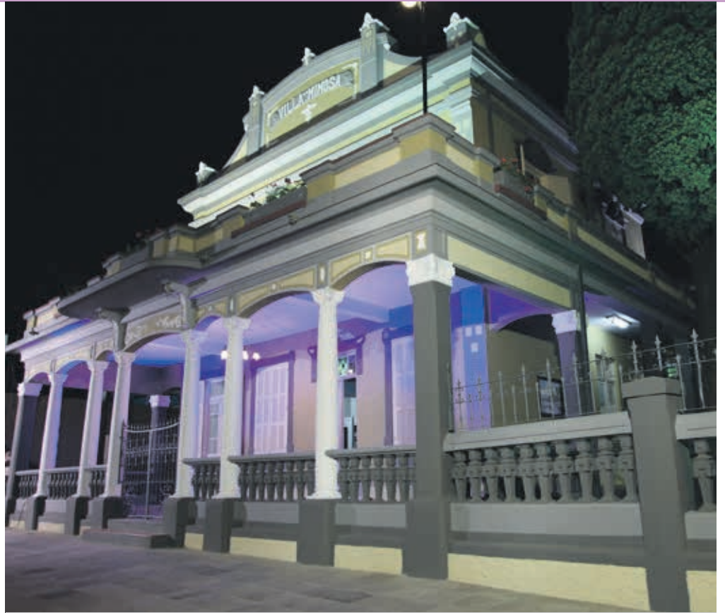
Restauração da Casa de Artes Villa Mimosa
