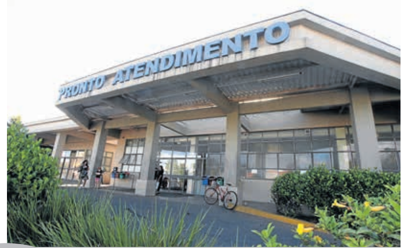
Reformas e readequações da área de Emergência do HPSC
