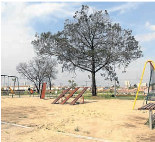
Construção da Praça Moinhos de Vento I
