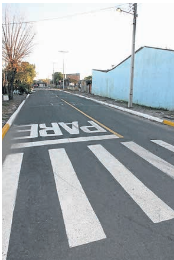
Asfalto da Rua Tchecoslováquia na João de Barro
