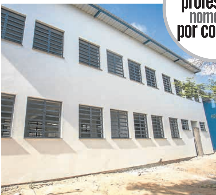
Reconstrução da EMEF Tancredo Neves (em obras)
