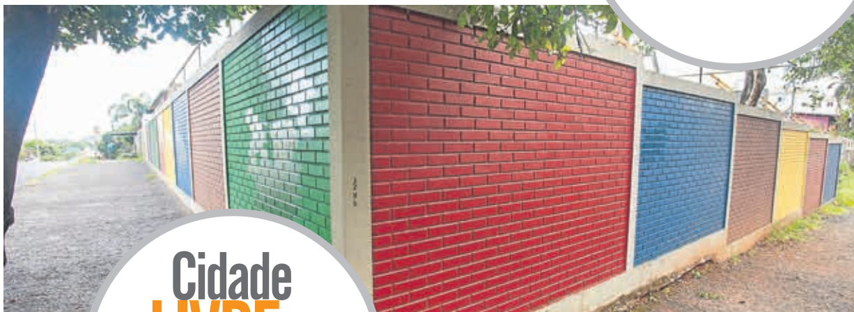
Novo muro na EMEF Irmão Pedro
