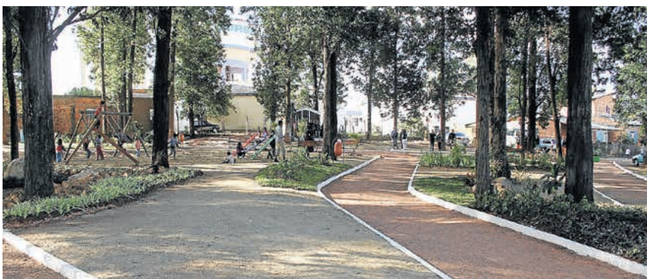
Construção da Praça da Gruta
