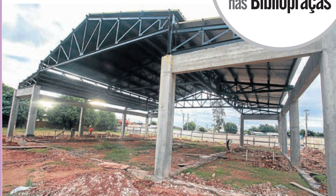
1º Hangar Cultural de Canoas está sendo construído no bairro Guajuviras
