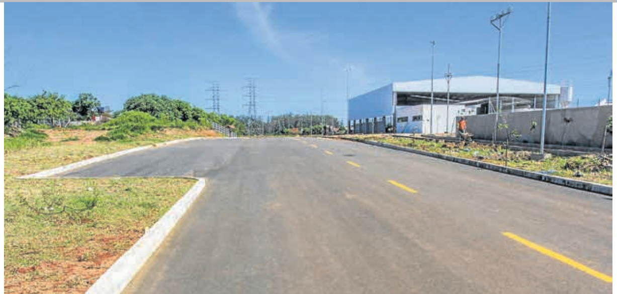
Asfalto da Rua 6 no Pôr-do-Sol no Bairro Guajuviras
