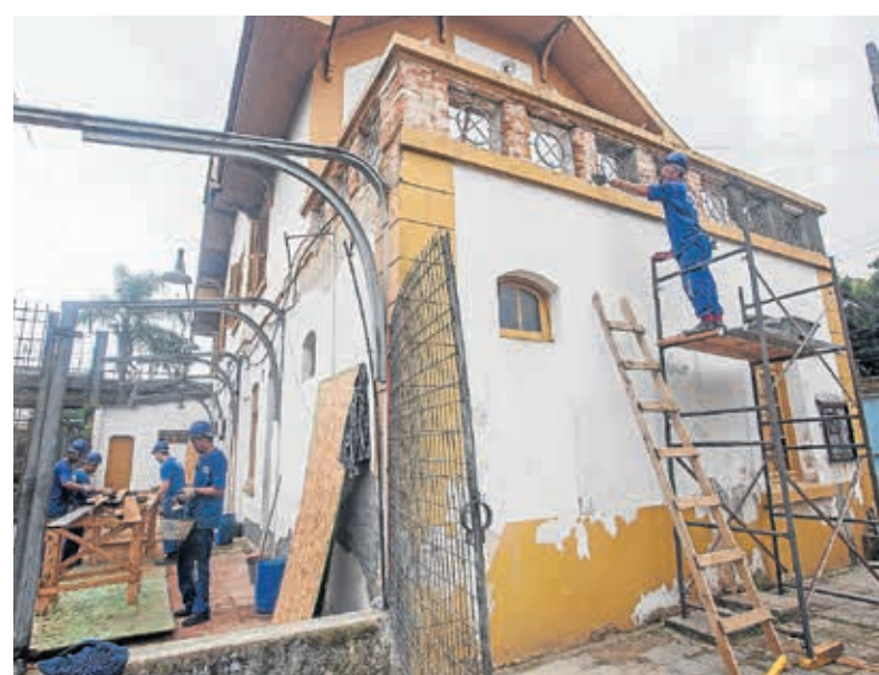
Prédio da antiga Estação Férrea está sendo reformado
