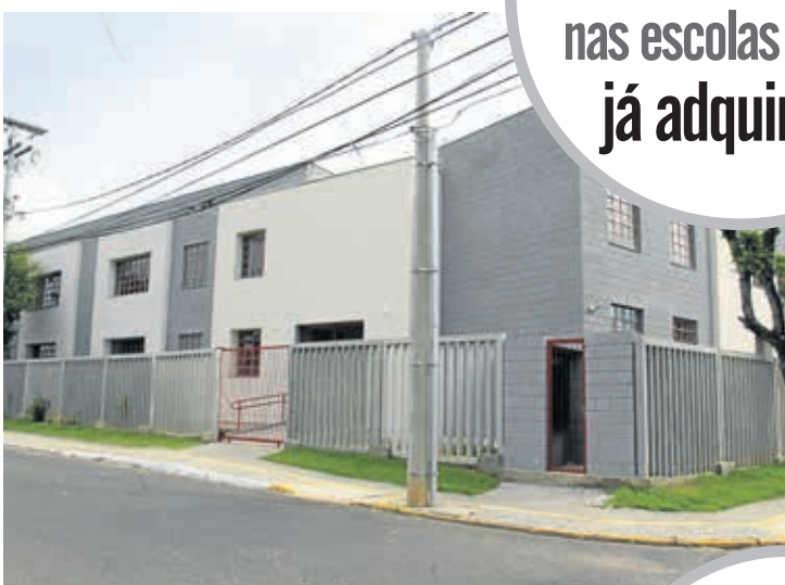
Reconstrução da EMEF Jacob Longoni (em conclusão)
