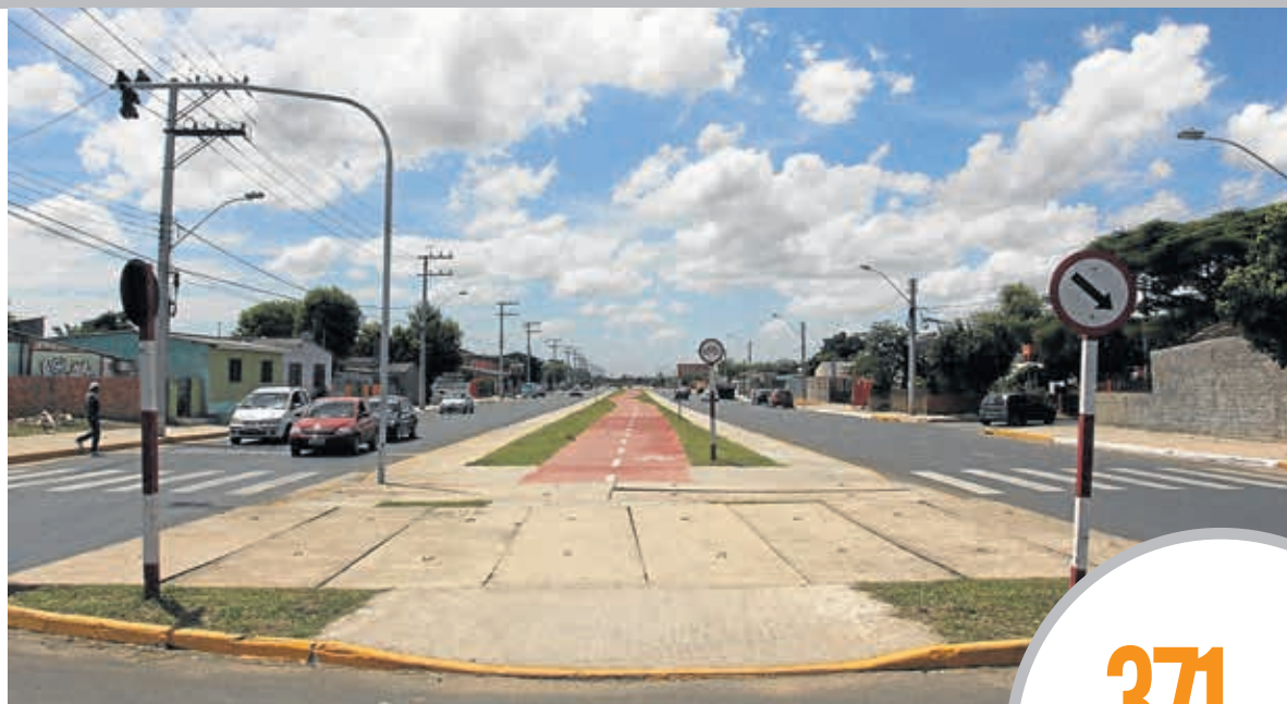
Pavimentação da Vala do Leão Trecho 7 no Bairro Mathias Velho
