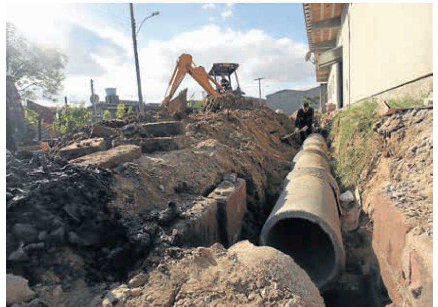
Obras de drenagem no Loteamento João de Barro
