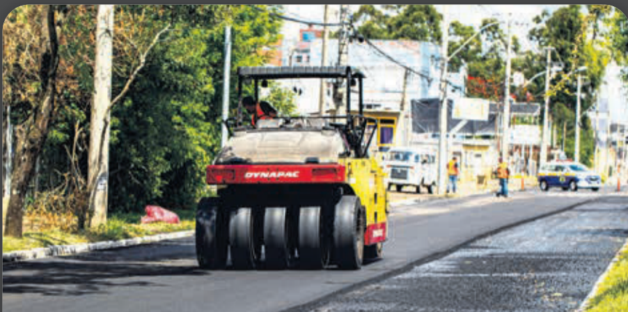
Revitalização asfáltica de 3.334 metros em andamento na Avenida Boqueirão (foto)
