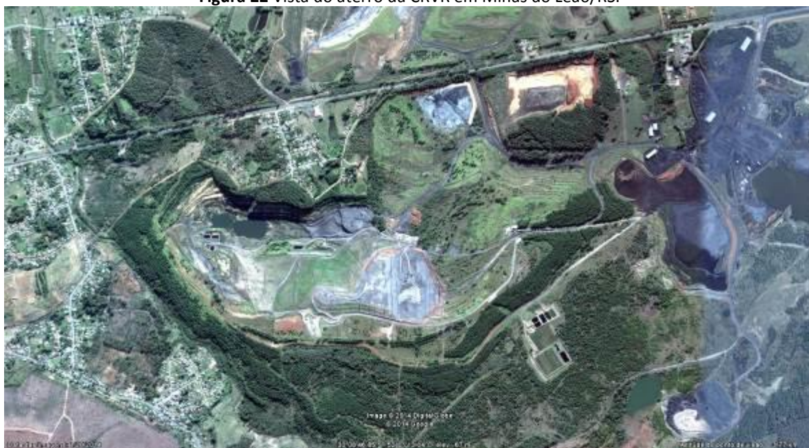
Figura 22 Vista do aterro da CRVR em Minas do Leão/RS.
