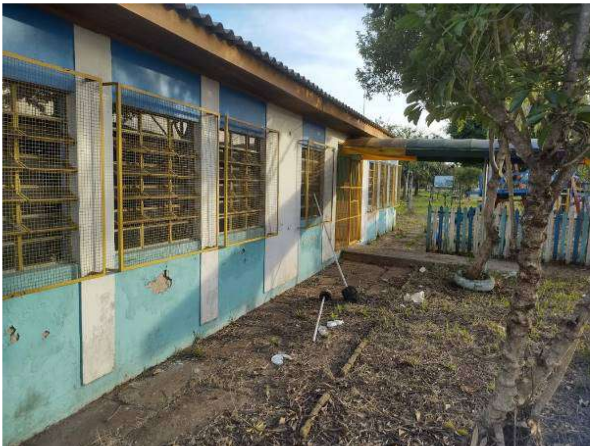
Foto da antiga EMEI Meu Pedacinho de Chão -prédio a ser reformado – imagem do autor em 24/05/2023
