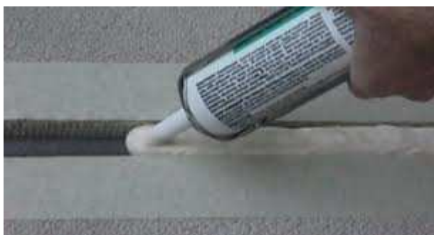
Imagem 4: aplicação e selante PU nas juntas de dilatação
