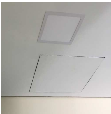
Imagem 7: alçapão para inspeção no forro moldura com perfil alumínio
