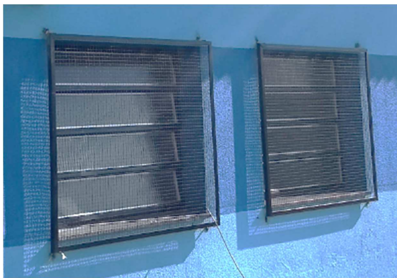
Imagem 11: exemplo de proteção das janelas com tela otis
