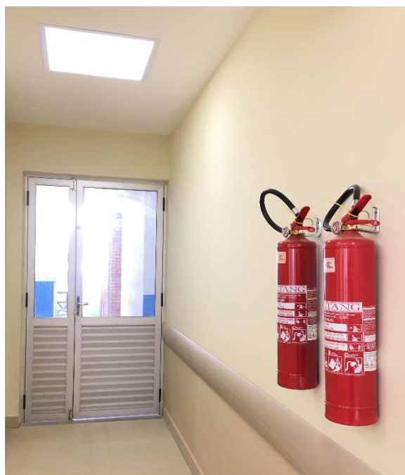
Imagem 8: vista do protetor de parede instalado numa unidade de saúde
