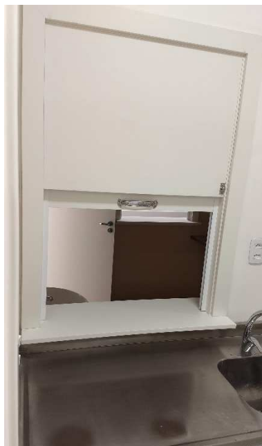
Imagem 9: vista do guichê entre a sala de utilidades e a CME
