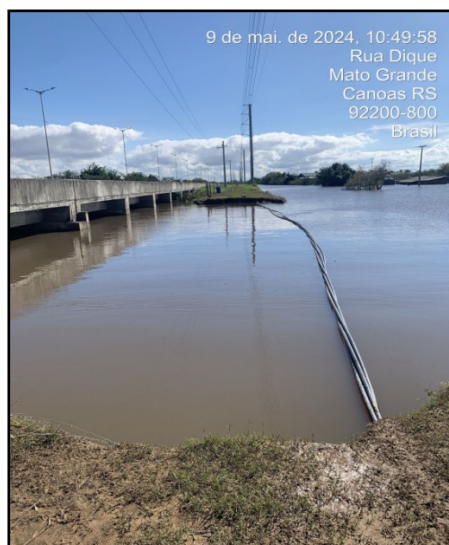
Figura 9: Ruptura do dique polder Rio Branco
