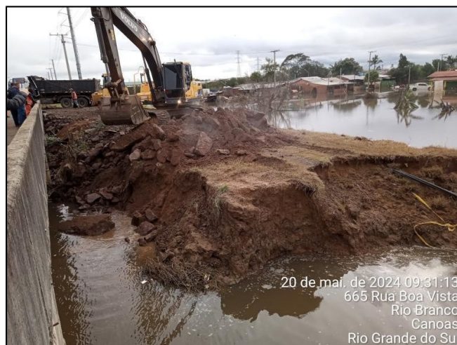
Figura 12: fechamento provisório dique Rio Branco
