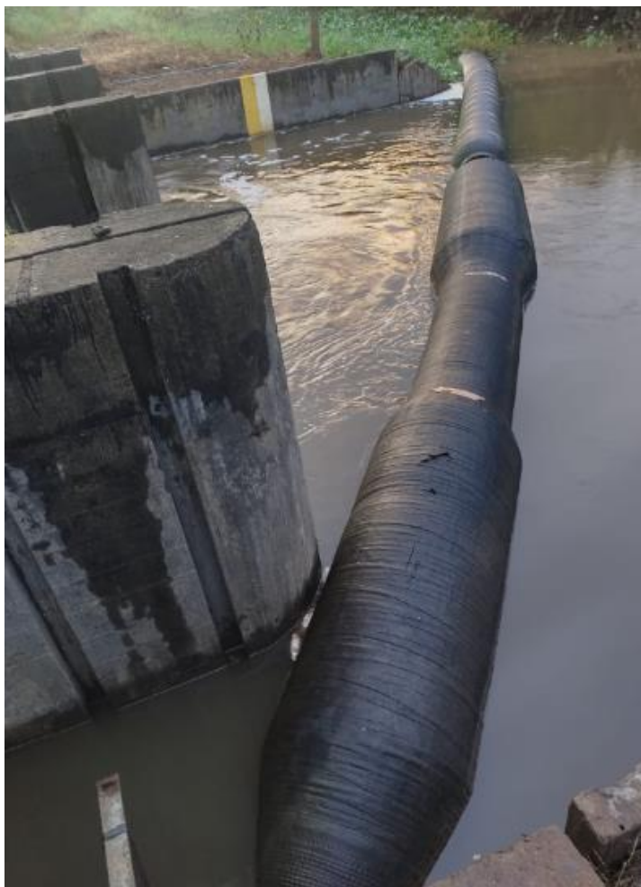
Figura 4 - Marcação de nível da entrada por pintura (ao fundo, no centro) e uma barreira de contenção
