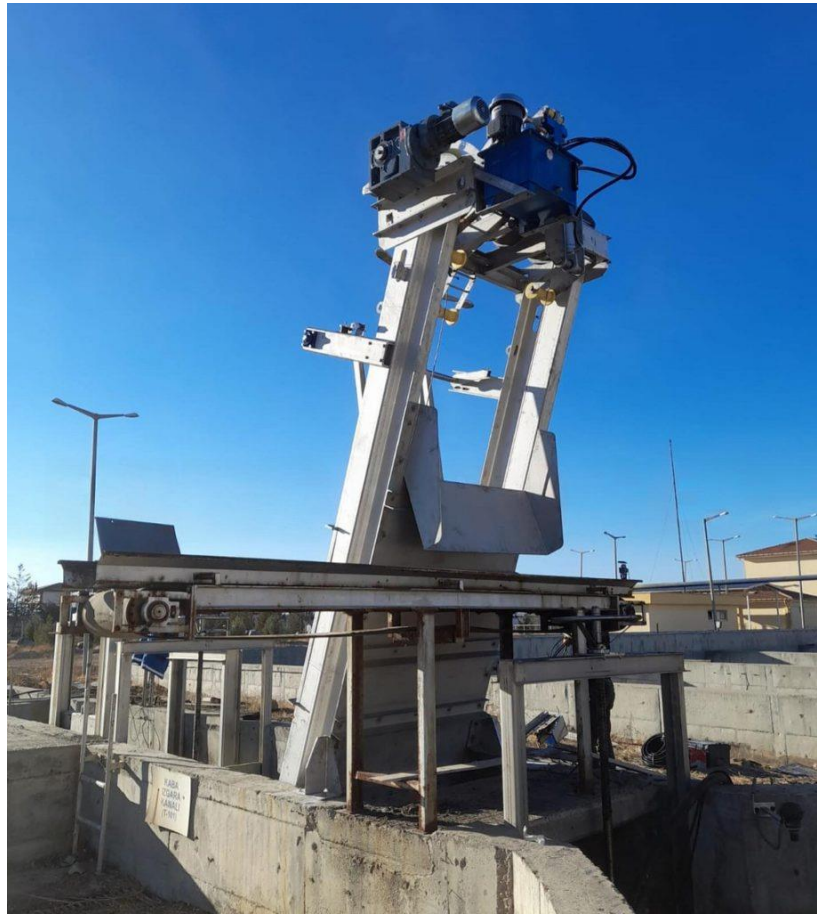
Figura 6 - Grade mecanizada operada por cabos (desconsiderar esteira)
