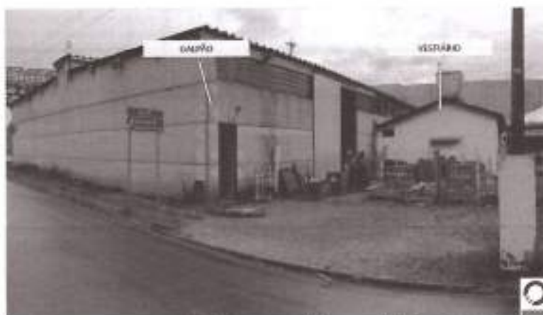
Figura 07 – Registro do galpão e vestiário na unidade CMPC, Guaíba.
